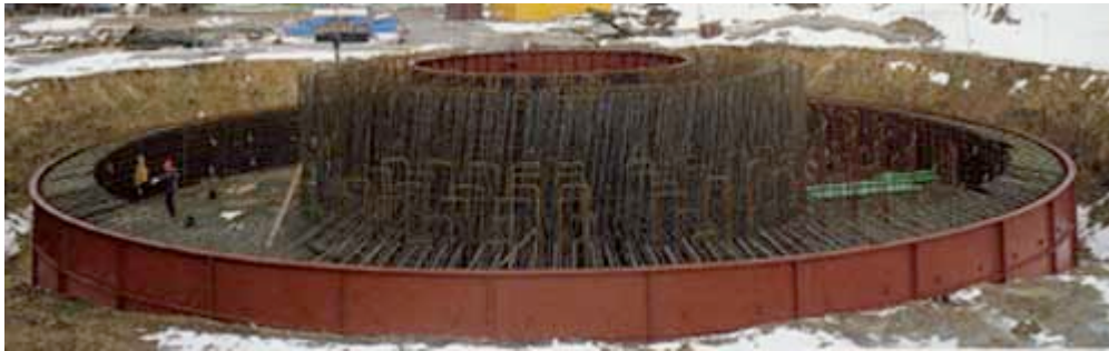
Enercon: Das Fundament der E-112 steht
