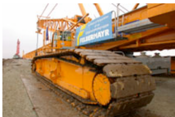
Schweres Geräte, der Raupenkran wurde mit 14 Sattelzügen angeliefert Foto: IG Windkraft
