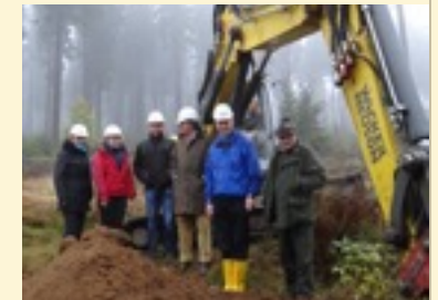
Der Baubeginn erfolgte im Oktober 2013, die nächsten Schritte folgen im Jahr 2015.
