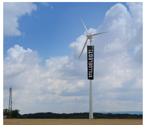
Stillgelegtes Windrad in Groissenbrunn/Engelhartstetten
