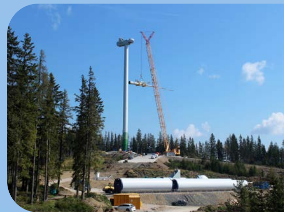
Die 58 Meter langen Flügel wurden via Bladelifter auf 1.350 Meter Seehöhe geliefert.
