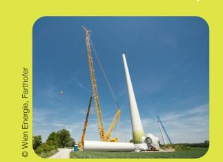
**Turm** – bis zu 170 m hoch und besteht aus Stahl oder Beton.
