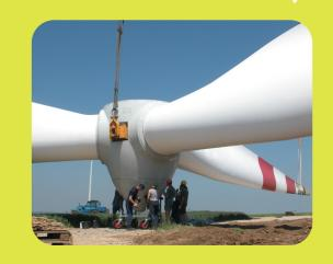
Rotoren – die drei Flügel werden direkt an der Nabe bereits am Boden oder in der Luft montiert.
