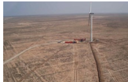
Errichtung einer V52 in Aserbaidschan
